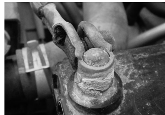
腐食したターミナル
